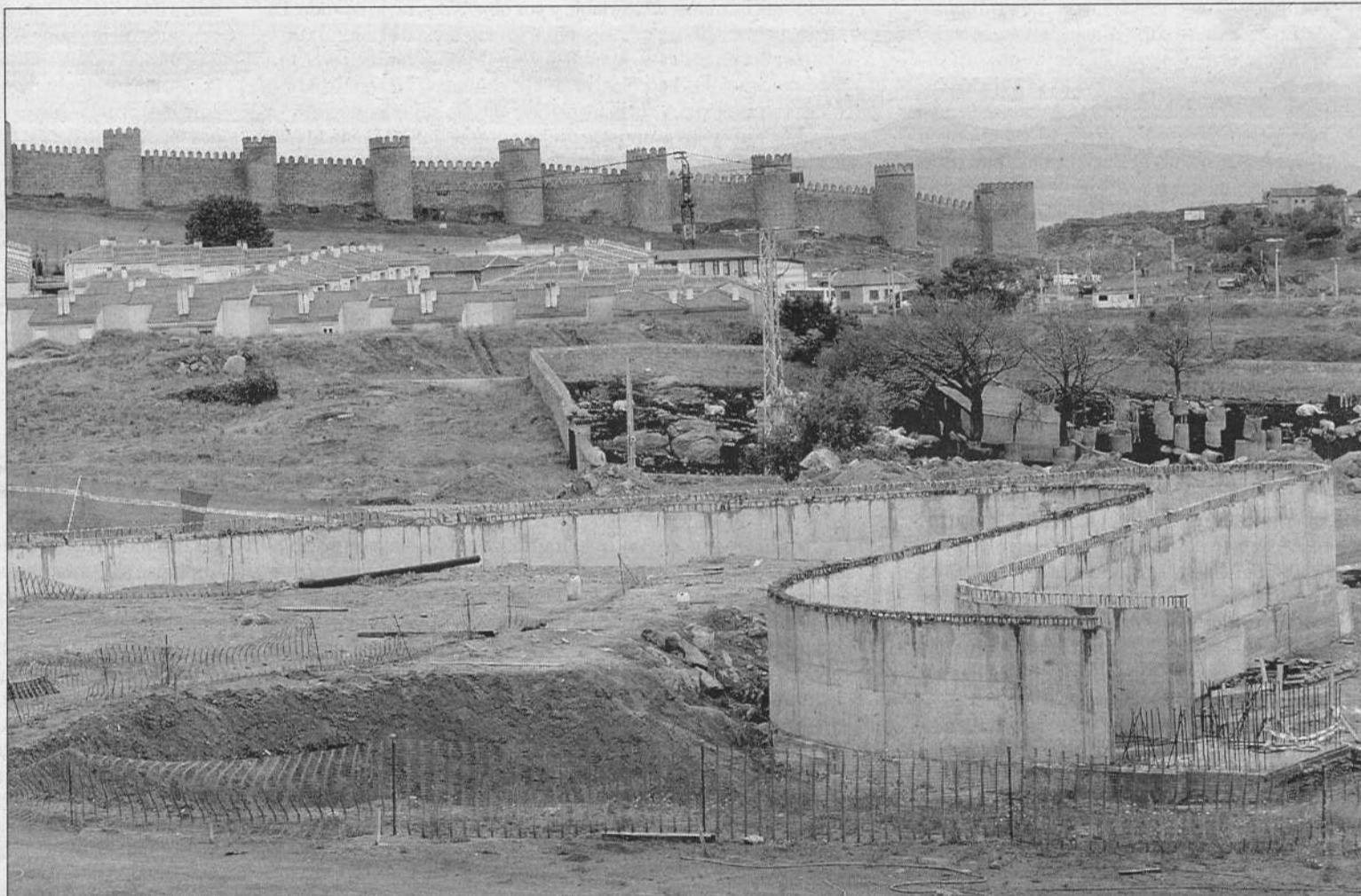
Obras de la futura Universidad de la Mística, promovidas por el Centro Internacional Teresiano Sanjuanista. / ANTONIO BARTOLOMÉ
